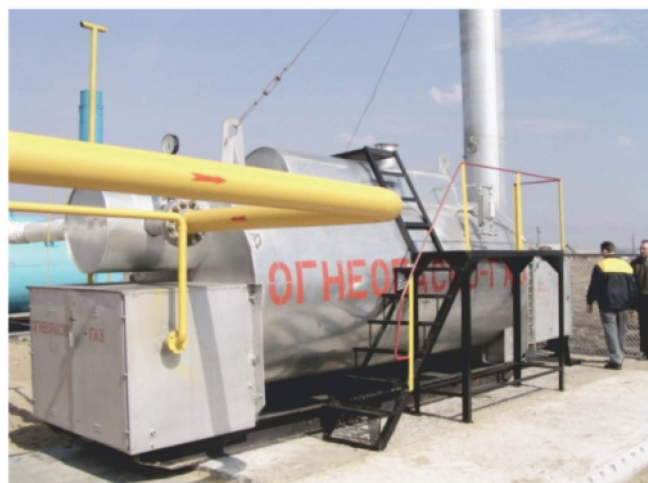
Подогреватель газа ГПМ-ПТПГ-10 ( Q=10000\text{м}^3/\text{ч} )
